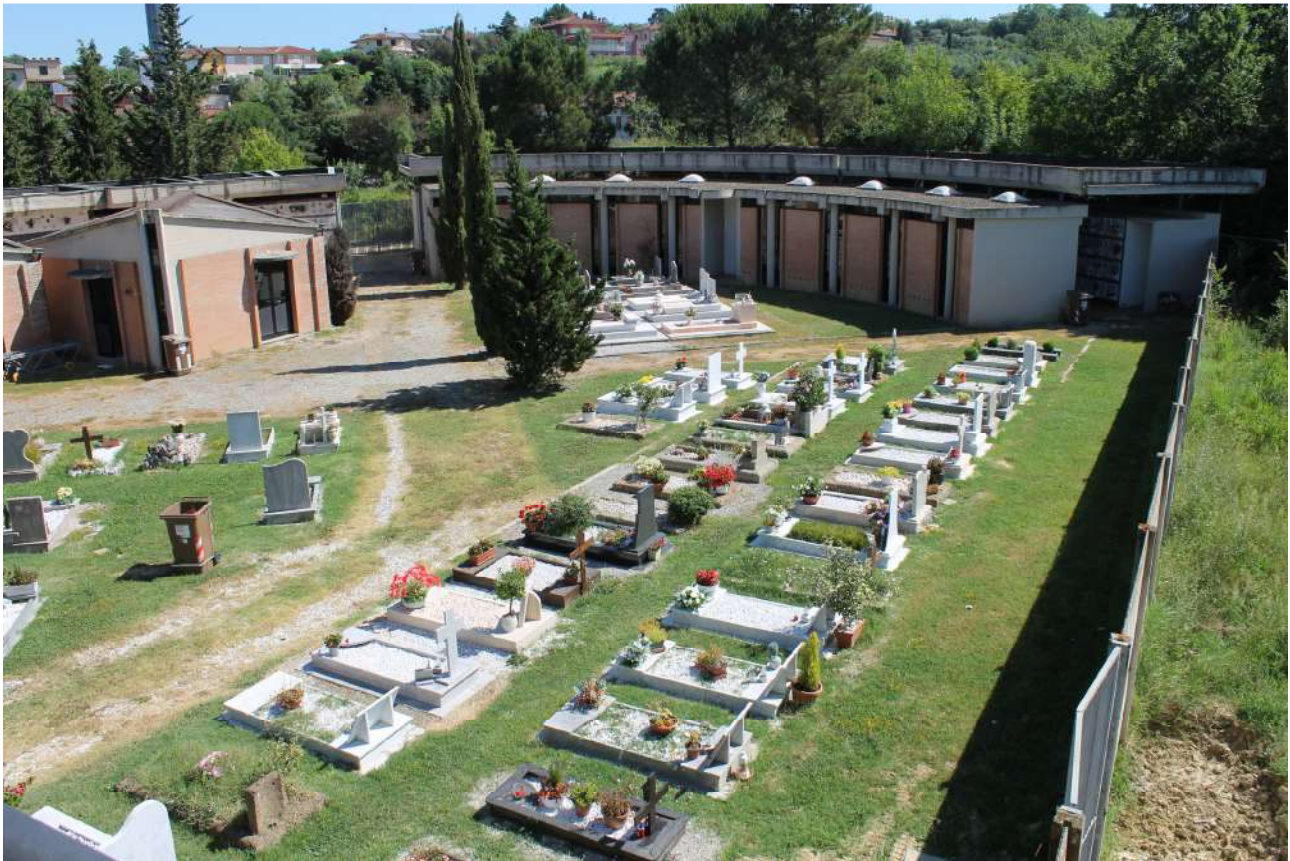
Foto 11: Vista della parte nuova del cimitero
