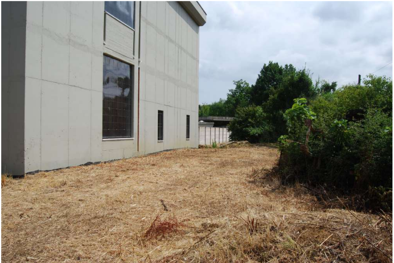
Foto 15: Lo spazio oggetto del futuro ampliamento sul fronte sud
